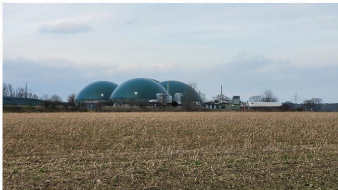
Planta de biogàs
