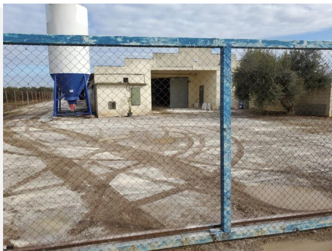
Figura 2. Desinfecció de l'exterior de la nau
