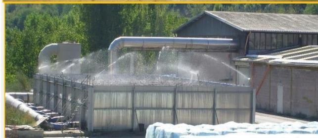
Figura 1: Instalación de compostaje interior y biofiltro externo.
