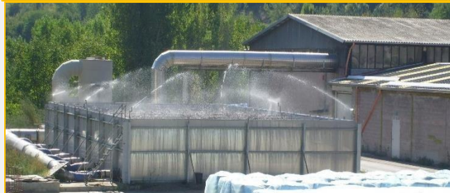
Figura 1: Instal·lació de compostatge interior i biofiltre extern.
