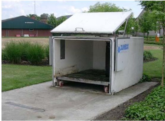
Espai aeri refrigerat per a un contenidor
