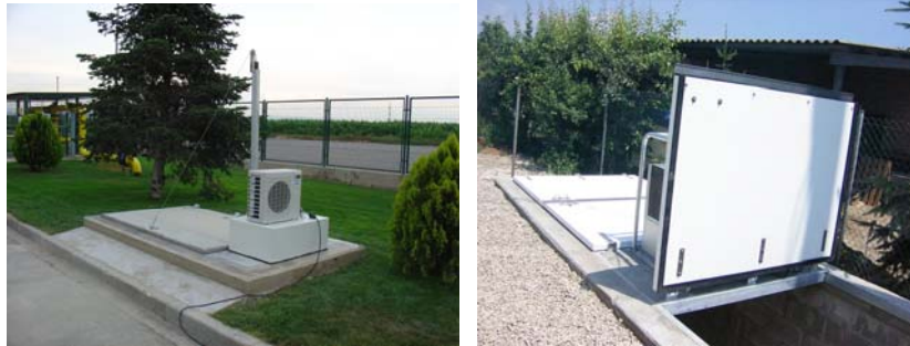
Espais subterranis refrigerats per a un i dos contenidors
