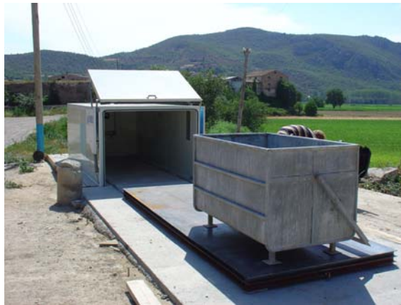
Espai aeri refrigerat per a dos contenidors
